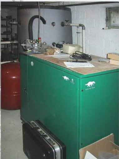
Blockheizkraftwerk
